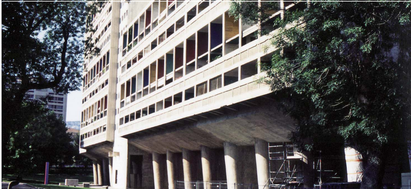
道路側の外観。1階は吹き放し(ピロティ)、この建築家が元祖です。
