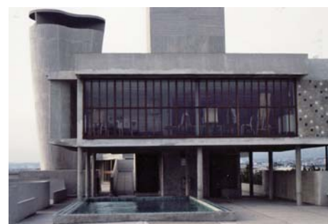
様々な機能を備えた屋上。
