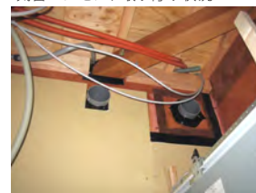
断熱材施工状況 (室内側に調湿気密シートを施工している) 設備用開口まわりの断熱状況
