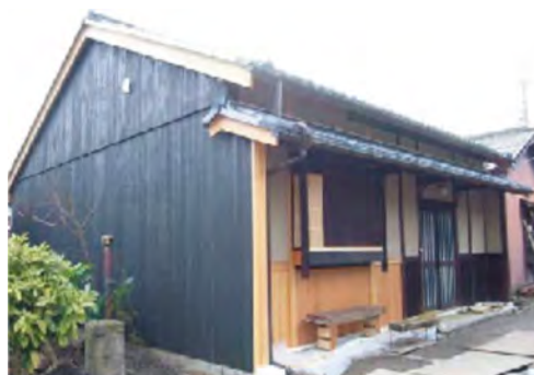
改修後：伝統工法を踏襲し見事に蘇った町屋外観
