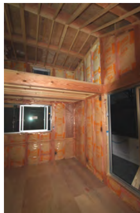
断熱材施工状況 (室内側に調湿気密シートを施工している) 設備用開口まわりの断熱状況
