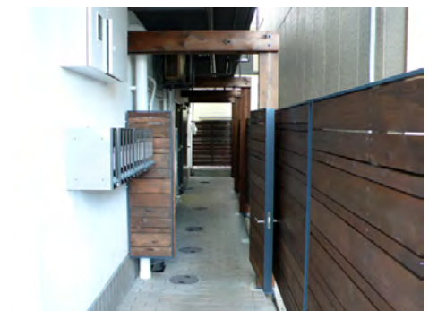
改修後の共用部 木材と鉄を使った門扉と塀を設けた
