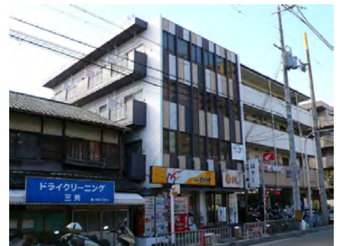
改修後の建物 道路側の外壁はタイル貼りとした
