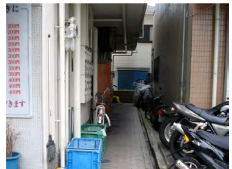
改修前の共用部 隣の建物の自転車等が雑然と置かれている
