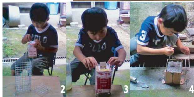
2: 作品が小さいため、鉄筋は焼肉用の金網を代用して組み上げました。 3: 内部が空洞になる様に牛乳パックを挿入し、投入口も忘れずに・・・ 4: コンクリートを流し込み、隅々まで行きわたる様、棒で突いて充填させます。
