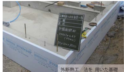
外断熱工法を用いた基礎
