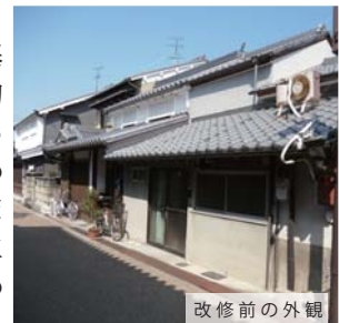
改修前の外観
