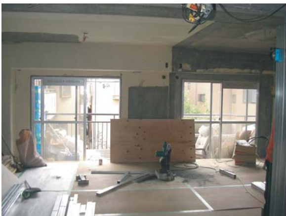
工事途中の様子
