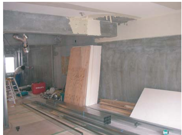
壁や天井下地を取り除いた後の様子
