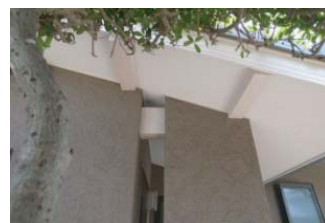
写真4: 増築した玄関の軒裏
