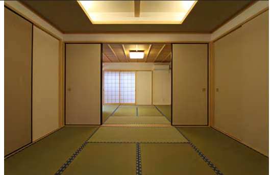
写真1：畳室手前は折上天井、奥は竿縁天井としている
