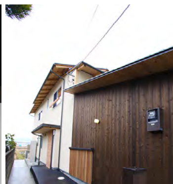
写真8：軒天井は大垂木・杉ムク板露しとしている
