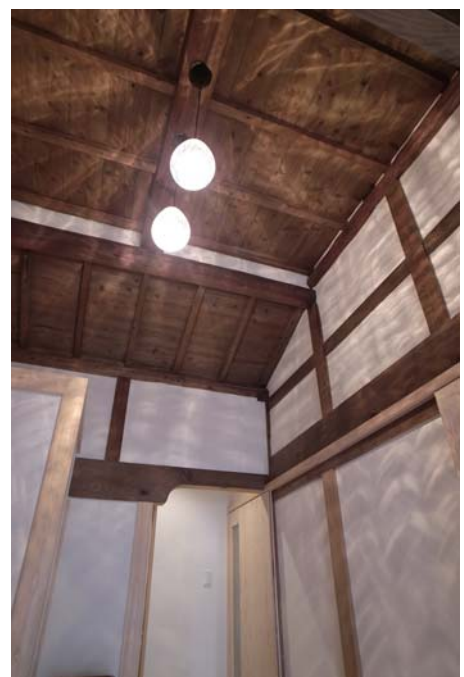
ホールの天井
