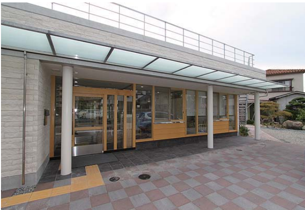
エントランスの連窓建具
