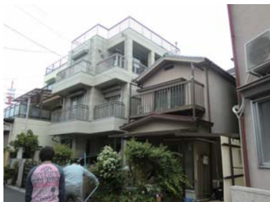
中央右の木造2階建て家が、建設予定地です。
