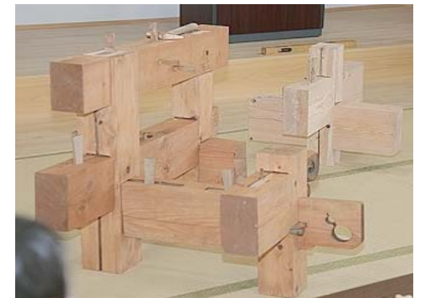
柱や梁の組み物
